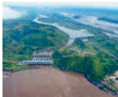
Рис. 193. Первые ГЭС на р. Конго
