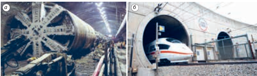
Рис. 109. Евротоннель: строительство тоннеля (1993 г.) (а), скоростной поезд в тоннеле (б)
