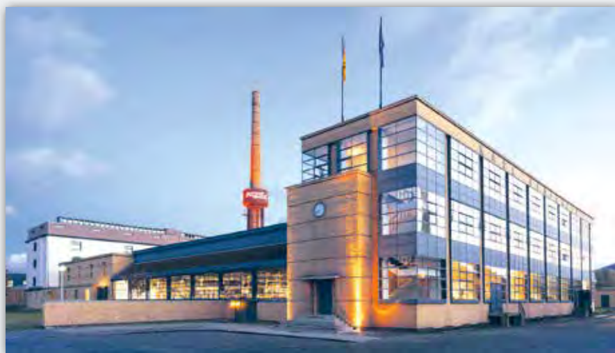
Архитекторы Вальтер Гропиус, Адольф Мейер. Обувная фабрика «Фагус» в Альфельде-на-Лайне, Германия (1910—1911 гг.)
