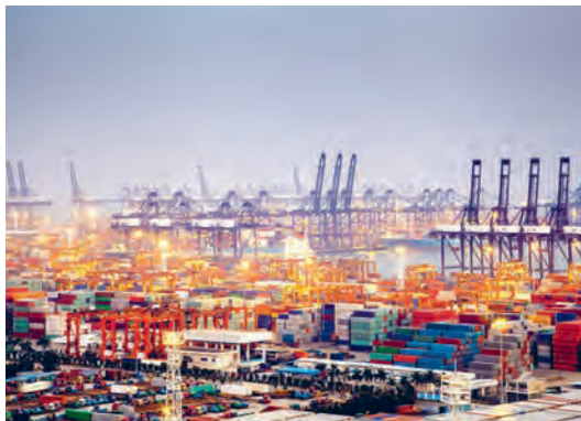
Рис. 191. Контейнерный порт Шэньчжэнь (Китай)
