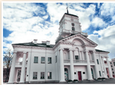
Здание восстановленной городской ратуши в Минске
