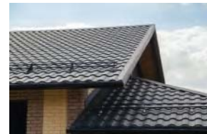
Полимерное покрытие на металлочерепице
