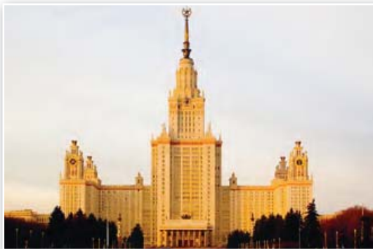
Главное здание МГУ. Москва, 1953 г. С 1947 по 1957 г. в Москве было построено 7 высотных зданий. «Сталинские высотки» являются вершиной послевоенного советского ар-деко
